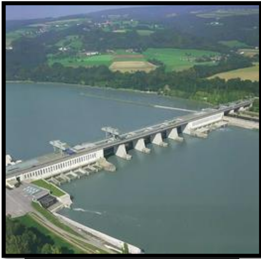
Barrage au fil de l'eau
